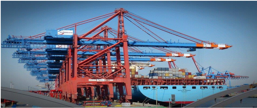
Figure 5 : portique à conteneur
