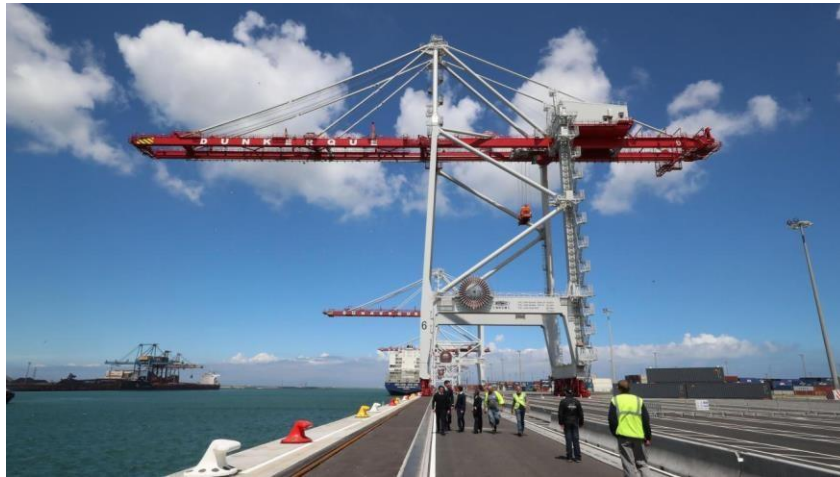
Figure N°01- 10: Grue de quai.
