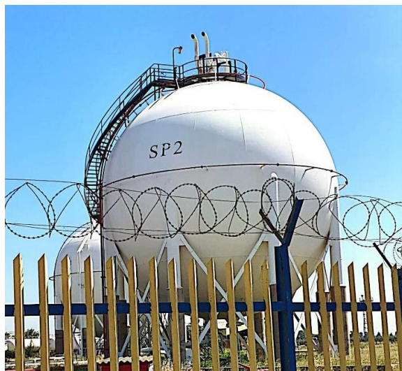
Figure III- 12 : Sphère de stockage de Propane alimentée par une pipe
