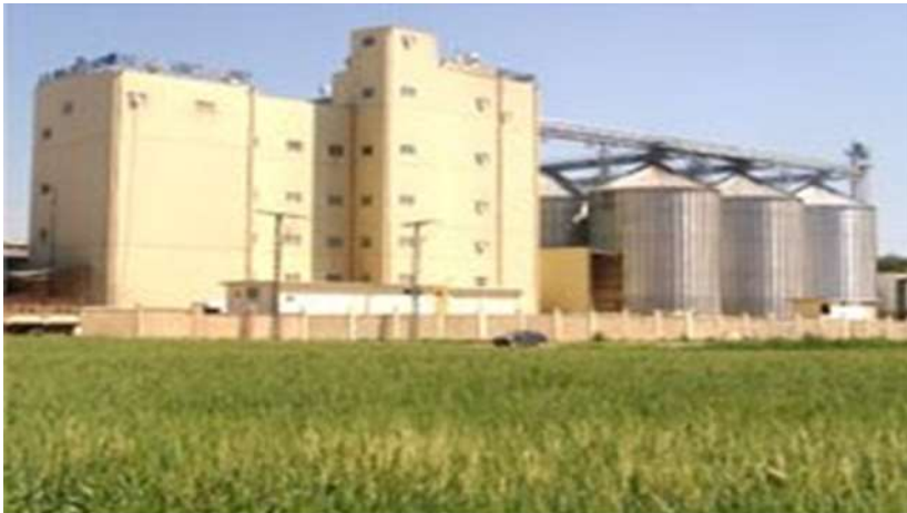
Figure N° 24 : Silos du blé
