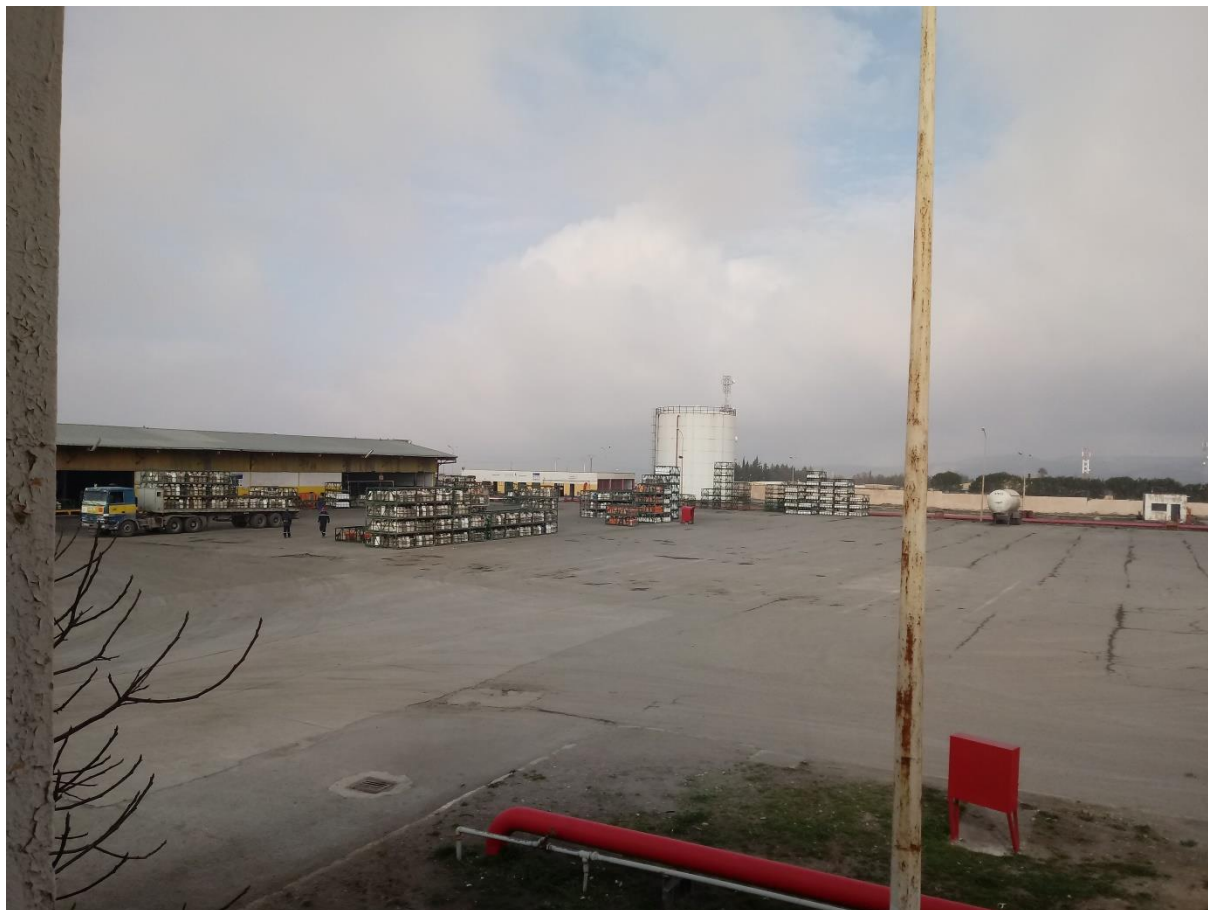
Figure N°08 : la zone de stockage des bouteilles de gaz
