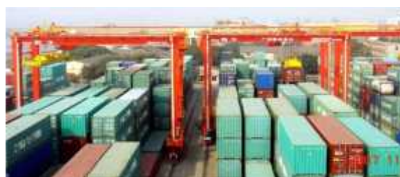
les RailMontedGantryCranes (RMGCs)
