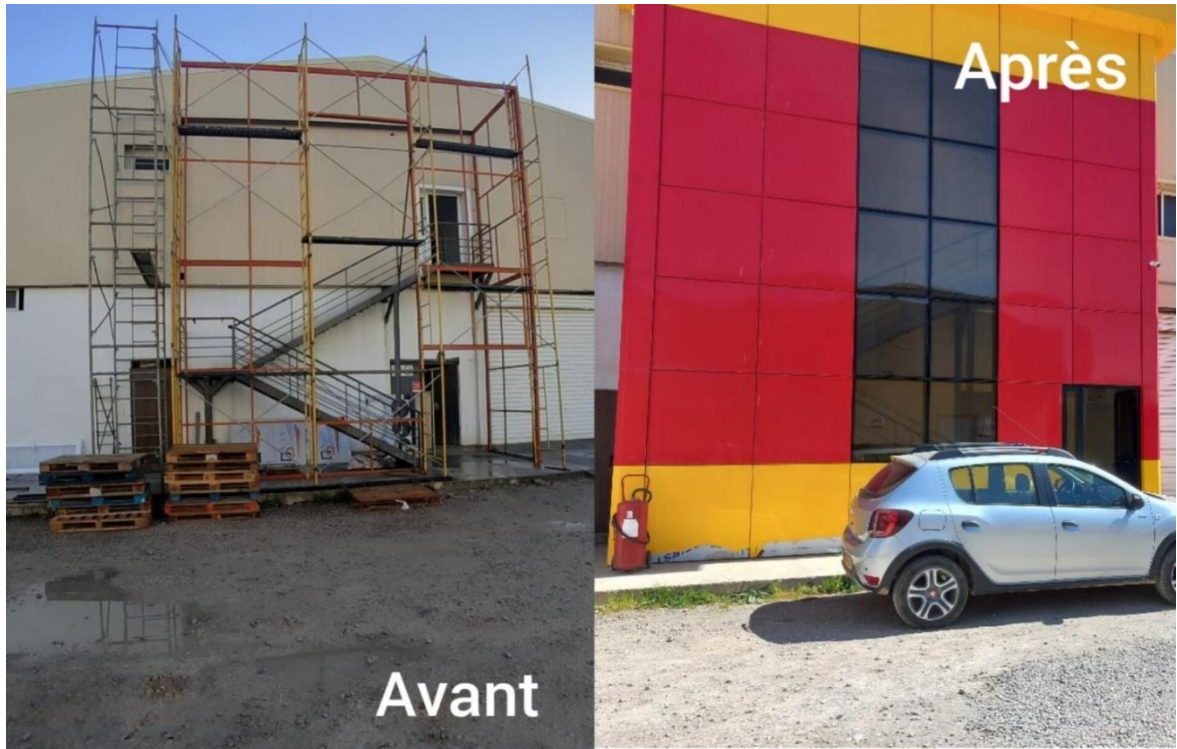
Figure 20: habillage de l'entrée des bureaux :
