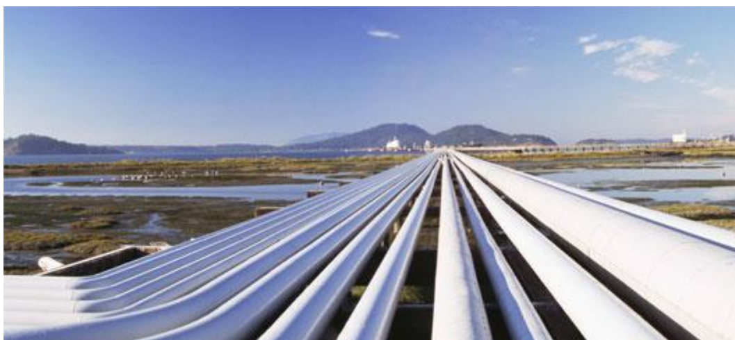
Figure 7 : Pipeline dans l'État de Washington
