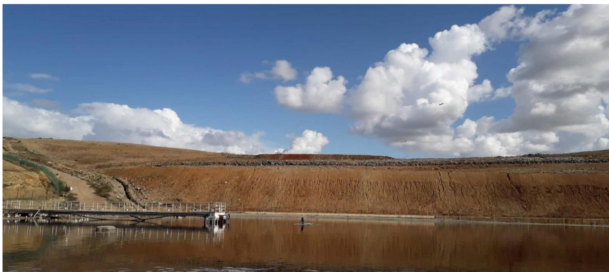
Figure 15 : Bassin de lixiviat
