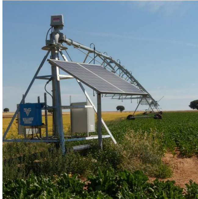
Figure n°02 : Un pivot d'irrigation fonctionnant à l'énergie solaire.
